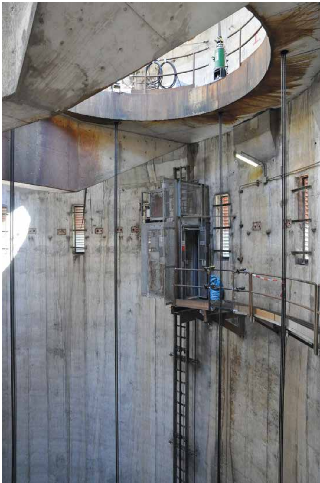
Stazione di arrivo dell'ascensore a quota 200 metri. Alla soletta del piano a quota 209 si accedeva tramite una rampa di scale visibile nella foto seguente
