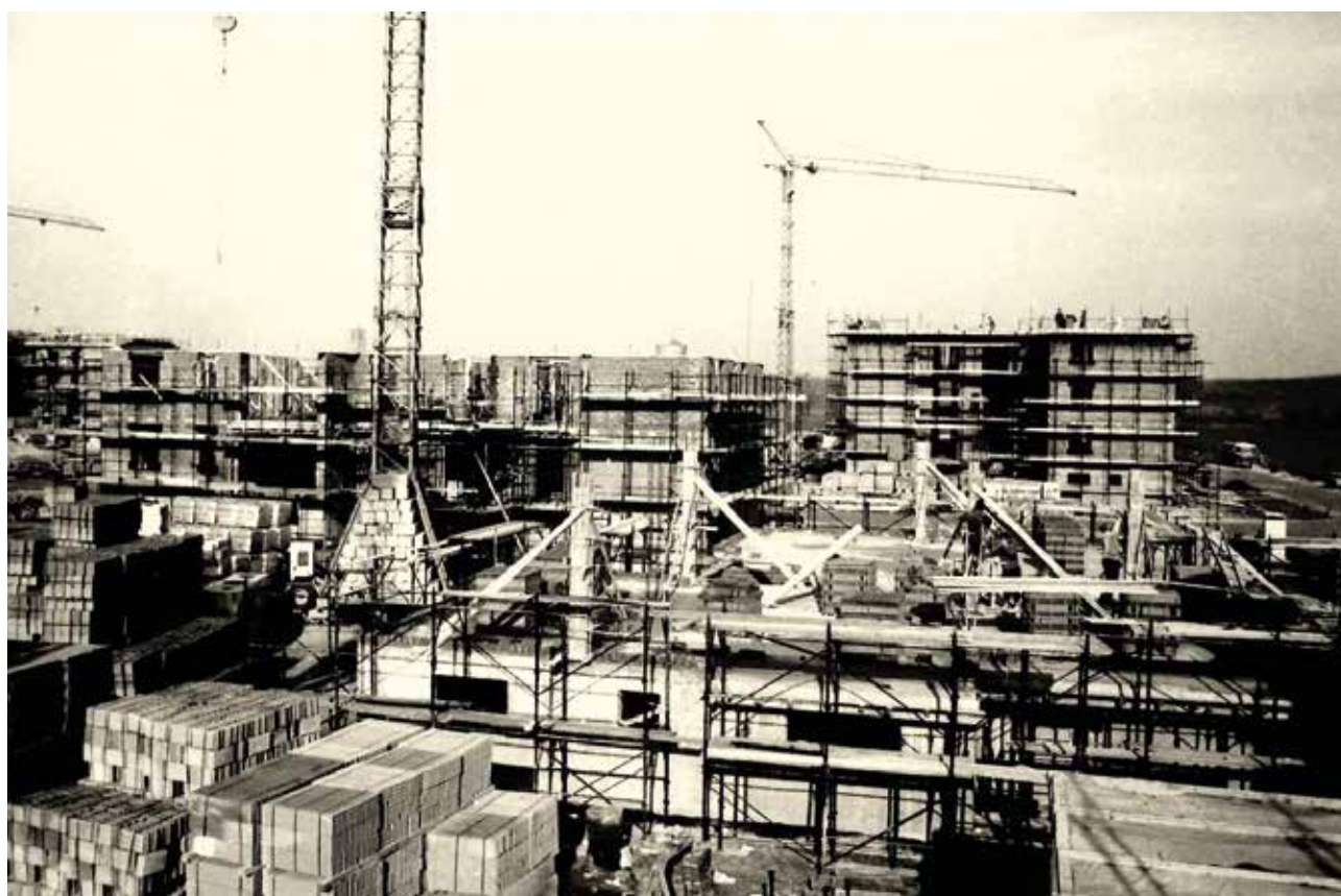
1980 Panoramica generale dei fabbricati in costruzione del nuovo villaggio
