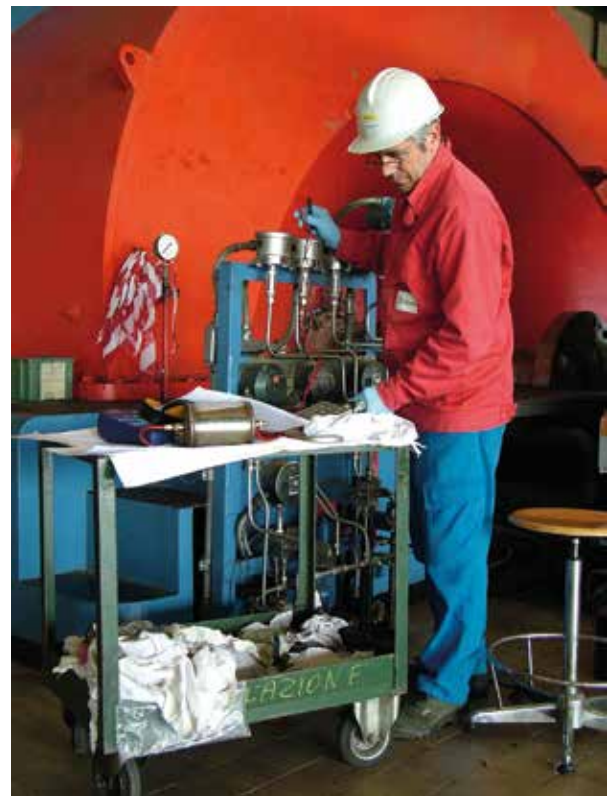
Taratura della strumentazione a protezione del turboalternatore
