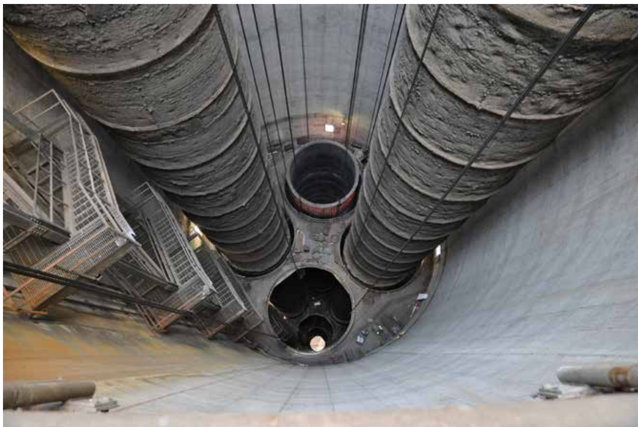
L'interno della ciminiera con la canna del gruppo 2 già completamente estratta e quella del gruppo 4 in fase di calaggio
