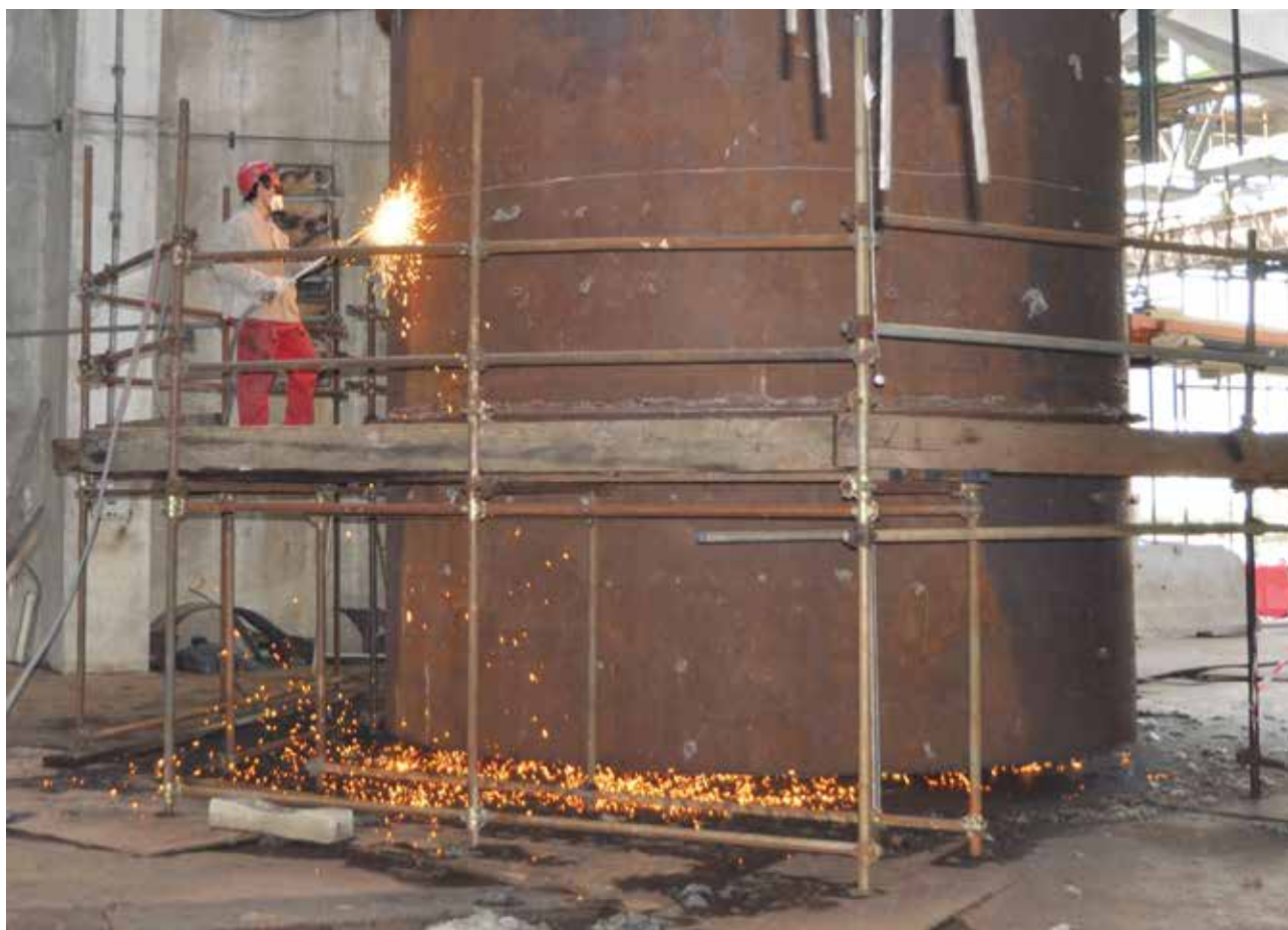
L'interno della ciminiera con la canna del gruppo 2 già completamente estratta e quella del gruppo 4 in fase di calaggio
