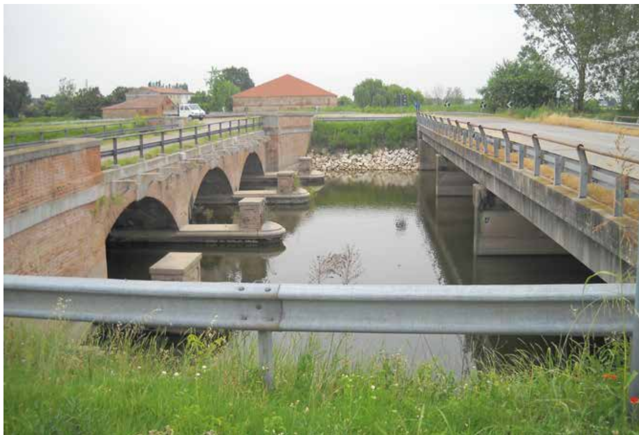
Nuovo ponte sulla strada provinciale costruito a fianco di quello esistente, sul canale Reggiano
