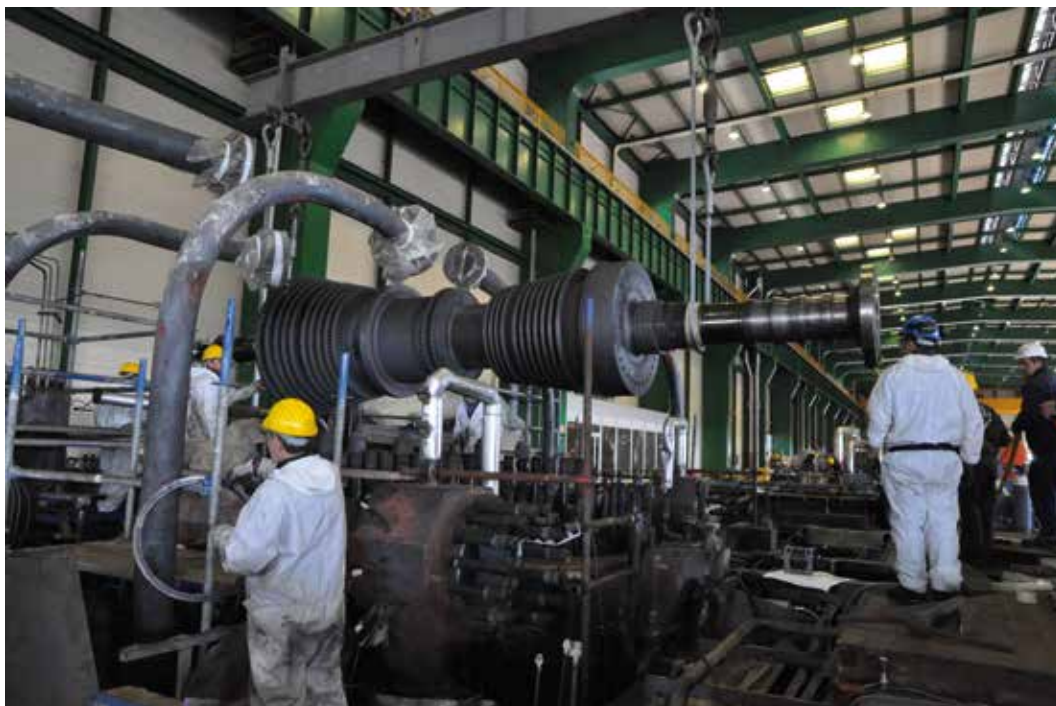
Fase di estrazione del rotore di Alta pressione di una turbina vapore
