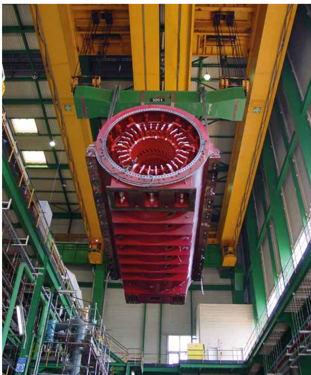
Fase di scambio dello statore del gruppo 3 con quello del gruppo 1; da notare i due carroponti accoppiati per poter sostenere il componente più pesante della Centrale
