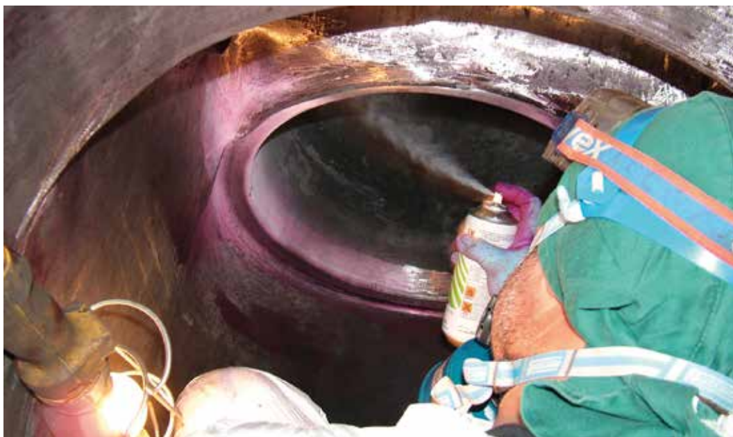
Controlli non distruttivi effettuati da personale dell'Unità servizi specializzati con liquidi penetranti in una valvola di riammissione vapore in turbina
