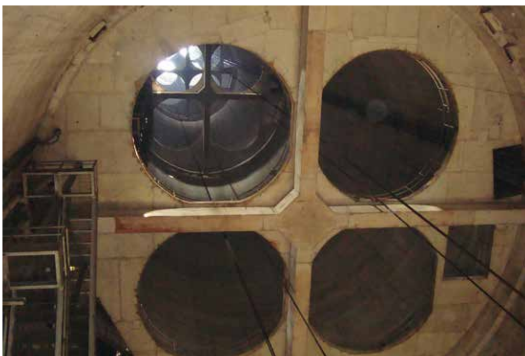
L'interno della ciminiera completamente svuotata dalle 4 canne. Sono visibili i 6 piani intermedi
