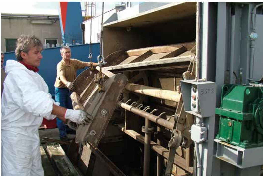
Rimontaggio dopo la manutenzione dei pannelli delle griglie filtranti all'opera di presa sul fiume Po
