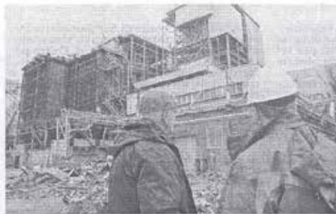
Una fase della ristrutturazione della centrale
