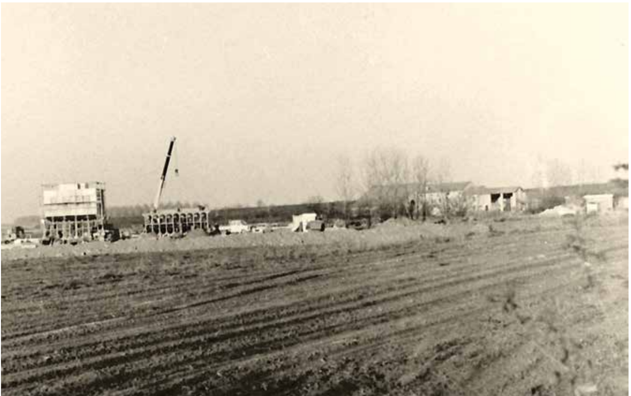
1975 Lavori di precarico terreno per successiva costruzione della C.T.E. Sulllo sfondo a destra la corte rurale Grossine
