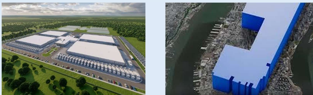
Figura 1.12. A sinistra: Progetto di ampliamento del data center Stargate I ad Abilene (Texas). A destra: Confronto tra il progetto del data center Hyperion di Meta in Louisiana e l'isola di Manhattan.
